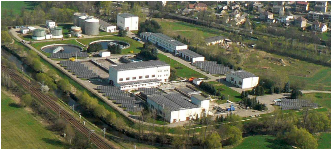
celkový pohled na FVE v Perknově, fotovoltaické panely jsou umístěny na střechách i volných plochách
